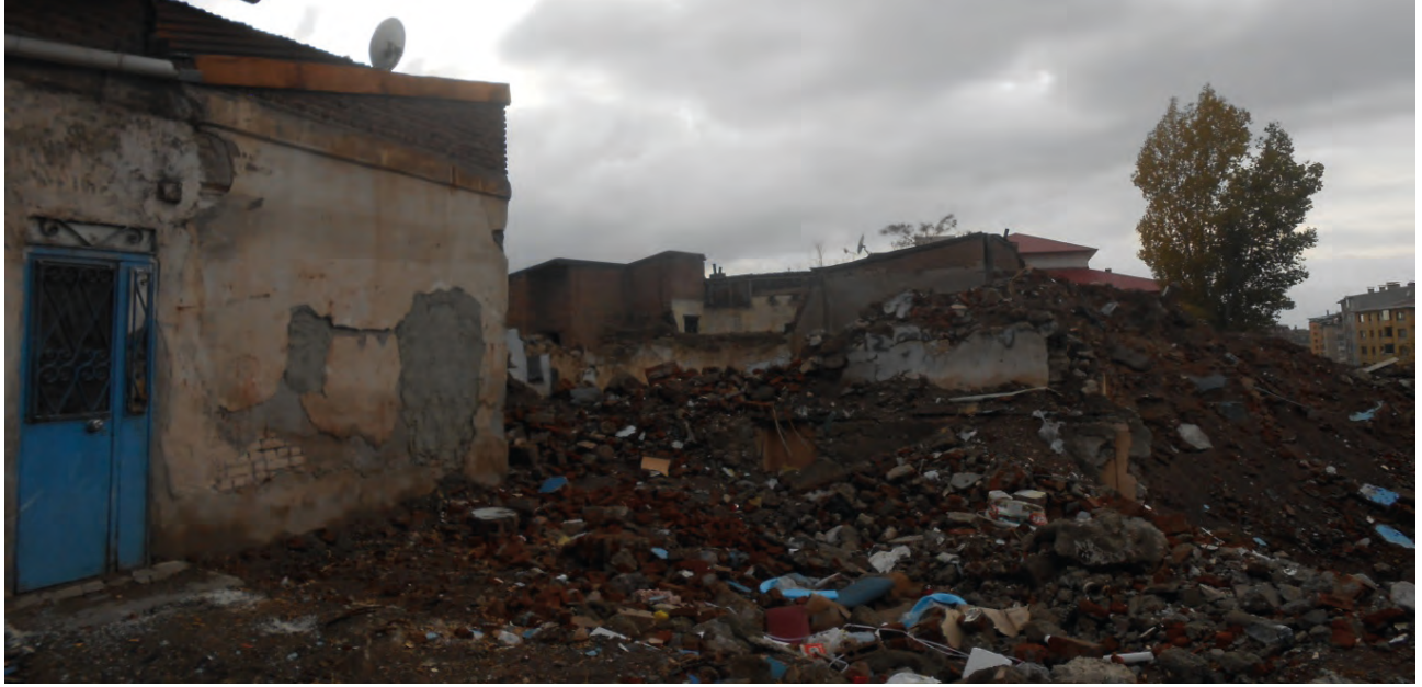
ÇIRÇIR MAHALLESİNDE BULUNAN GECEKONDULARIN YERİNDE YAPILAN TESPİT
